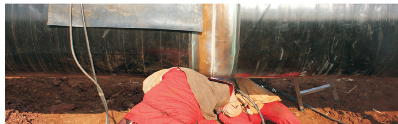
Синьцзян-Уйгурский автономный район, компания «Ойлфилд Констракшн» Заполнение и облицовка шва самозащитной проволокой
