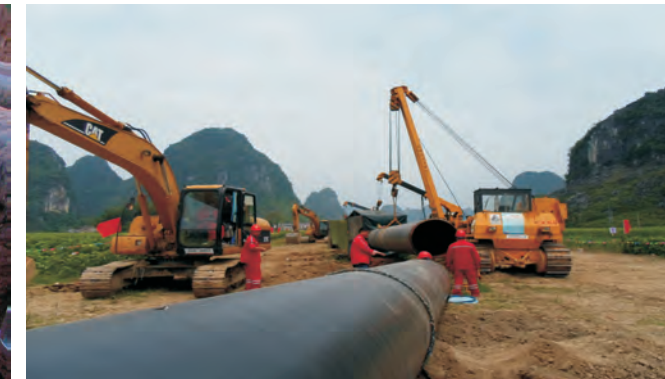
Сычуань, компания «Ойлфилд Констракшн» Заполнение и облицовка шва самозащитной проволокой
