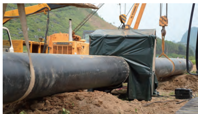
Участок второй ветки западно-восточного газопровода в провинции Ганьсу Провинция Цинхай, компания «Ойлфилд Констракшн» Сварка корня шва метллопорошковой проволокой
