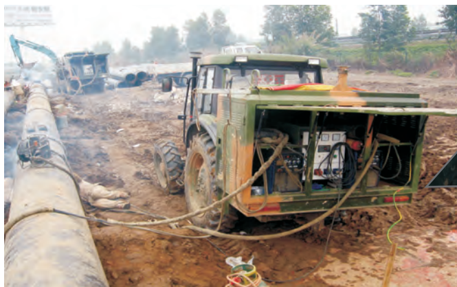
Участки газопровода между провинциями Сычуань и Гуандун СРОЕ Сварка облицовки аппаратом DC400
