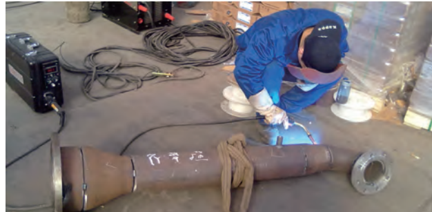
Сварка сосудов высокого давления
