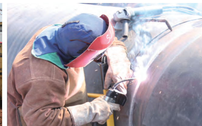
Нефтяное месторождение Шэнли, компания «Ойлфилд Констракшн» Заполнение и облицовка шва самозащитной проволокой
