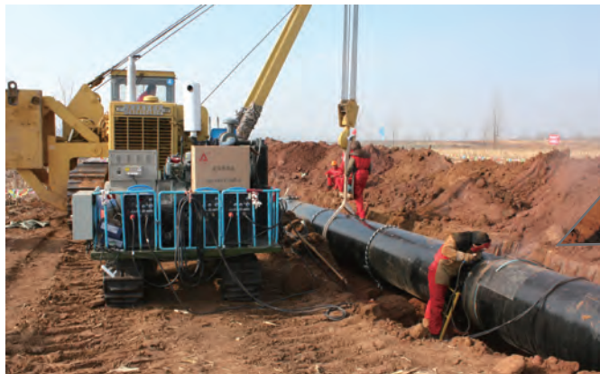
Участки трубопровода для газа в провинции Шаньдун SLPCSC Сварка облицовки аппаратом DC400
