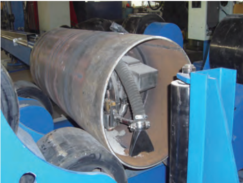
Внутренняя сварка труб малых диаметров
