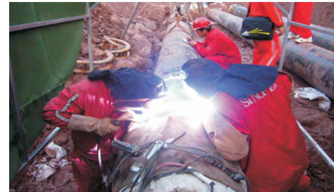
Жонъюан, компания «Ойлфилд Констракшн» Сварка корня шва метллопорошковой проволокой
