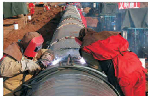
Участки трубопровода для газа в провинции Шаньдун SLPCSC Сварка облицовки аппаратом DC400
