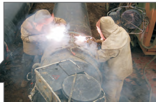
Участки газопровода между провинциями Сычуань и Гуандун СРОЕ Сварка облицовки аппаратом DC400
