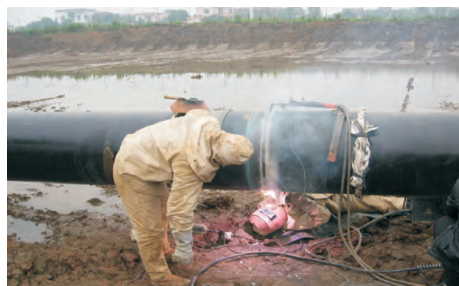
Участок второй ветки западно-восточного газопровода в провинции Ганьсу Провинция Цинхай, компания «Ойлфилд Констракшн» Сварка корня шва метллопорошковой проволокой
