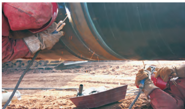
Участок во Внутренней Монголии Нефтяное месторождение Шэнли, компания «Ойлфилд Констракшн» Сварка корня шва электродом с целлюлозным покрытием
