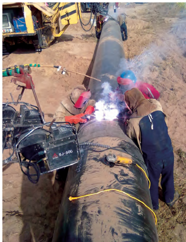
Участок в Фэннин-Маньчжурском автономном уезде (провинция Хэбэй), компания «Датанг Интернешнл Пауэр Дженерейшн Ко., Лтд.» Заполнение и облицовка шва самозащитной проволокой
