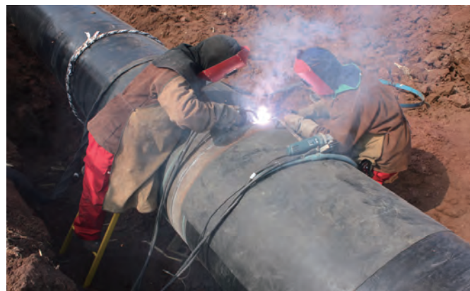
Участок второй ветки западно-восточного газопровода Заполнение и облицовка шва самозащитной проволокой
