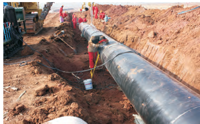
Участок сети трубопровода для транспортировки природного газа провинции Шаньдун Заполнение и облицовка шва самозащитной проволокой
