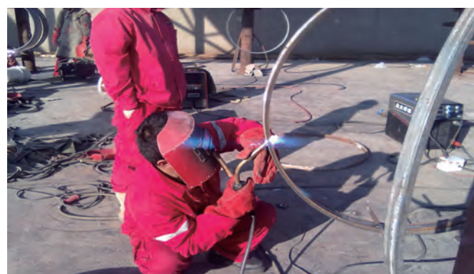
Второе нефтяное месторождение Шэнли, компания «Ойлфилд Констракшн» Сварка корня шва методом STT
