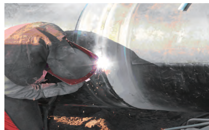
Участок второй ветки западно-восточного газопровода в провинции Ганьсу Заполнение и облицовка шва самозащитной проволокой
